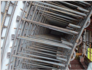
トンネル（アーチ部）
