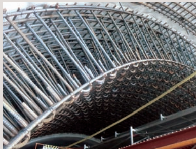
トンネル（アーチ部）
