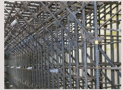
ボックスカルバート（隅角部）
