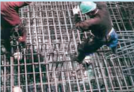
マットスラブせん断補強鉄筋配筋状況
