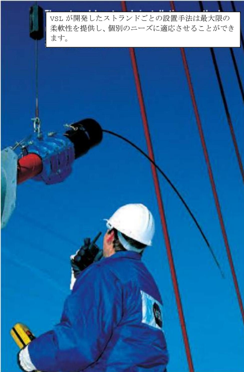
全ての SSI 2000 のケーブルは、とてもコンパクトな機器を使用してストランドごとに設置され、必要になれば同じように検査や交換ができます。
