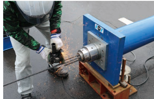
① ディスクグラインダーで鋼線を切断 アンカーヘッドの前面より110mm程度余長として残す
