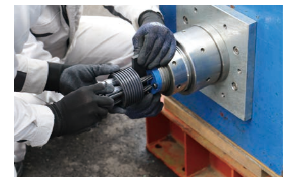
② プーリングヘッドにグリッパー取付
