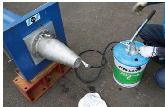
④ ヘッドキャップ内防錆油充填
