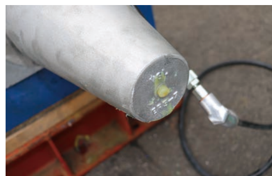
⑤ 防錆油の充填確認
