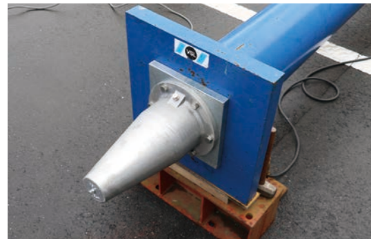
③ ヘッドキャップ設置
