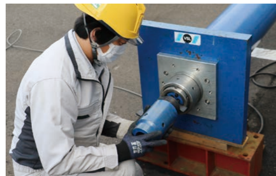
③ プーリングヘッド及びブルカップラーの取付
