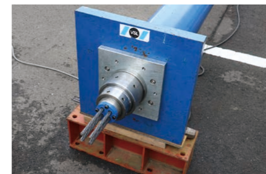
① クリアランスプレートの設置
