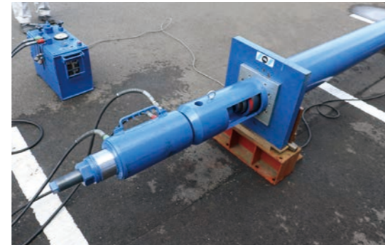
② 所定の荷重まで緊張作業・定着
