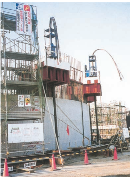
施工中のVSLリフティング装置
