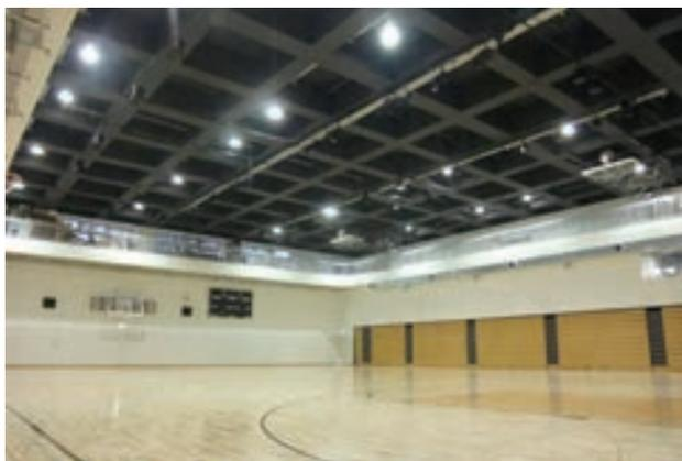
学校の体育館として必要な面積を、2.85m×2.75mを基本グリットとする梁せい1.1mの場所打ちPC格子梁で施工し28.5m×33.0mの無柱空間を実現しています。
