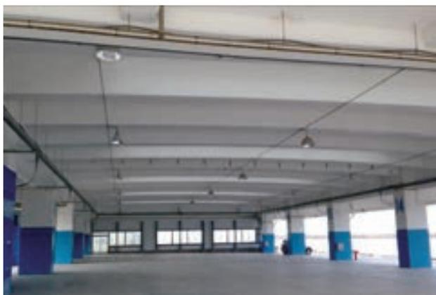
鮮魚を水揚げし、搬送用の車両が自由に走り回る空間が必要な為、スパン22.0m、桁行きスパン9.0m、さらに建物の周囲には5～6mの片持ち梁で、現場打ちPC梁を採用し実現しています。
