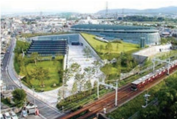
平面・立面方向ともに勾配のある27.0mの無柱空間に梁せい1.5mの場所打ちPC梁を採用することで、非常に開放感がある変化に富んだ空間としています。
