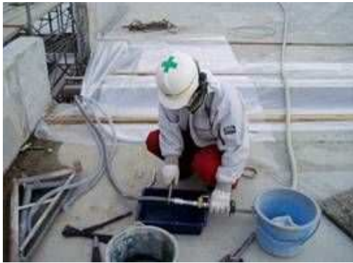
PCグラウト注入状況
