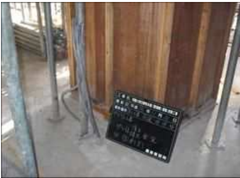
PCグラウト注入確認(中間排気口)
