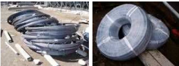
PC鋼材保管例(シートをはずした状態) グラウトホース保管例
