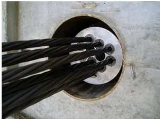
定着くさび取付け完了
