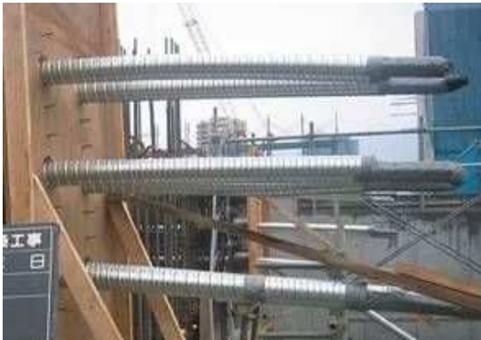
ストランド余長部分の養生
