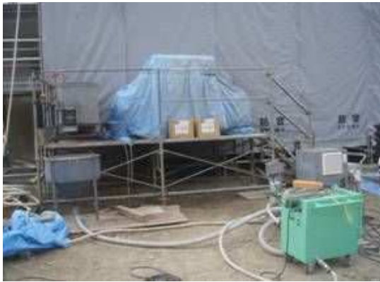
PCグラウト材ストック状況
