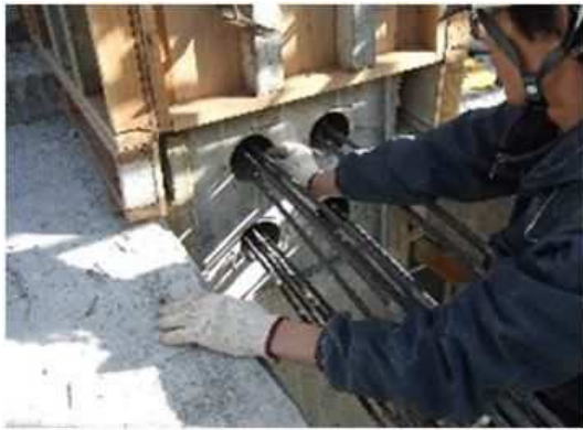
定着くさび取付け状況
