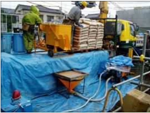
PCグラウト機器設置状況
