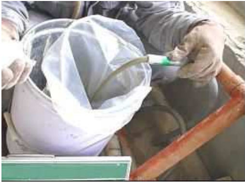
排出口PCグラウト濃度確認
