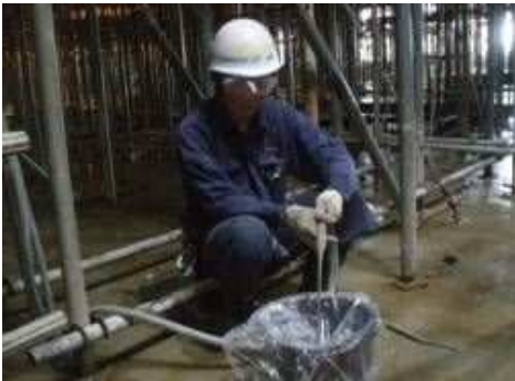
PCグラウト排出状況
