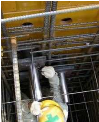
定着具の取付け
