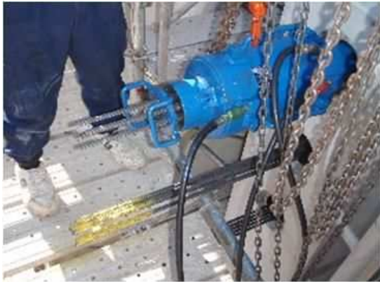
緊張作業状況
