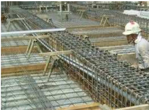
落とし込み方式例
