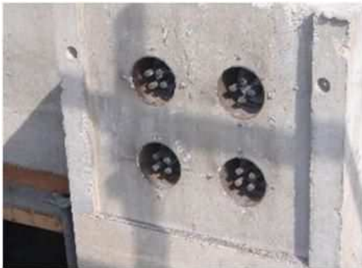
PC鋼材余長切断完了
