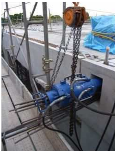
緊張ジャッキのセット状況
