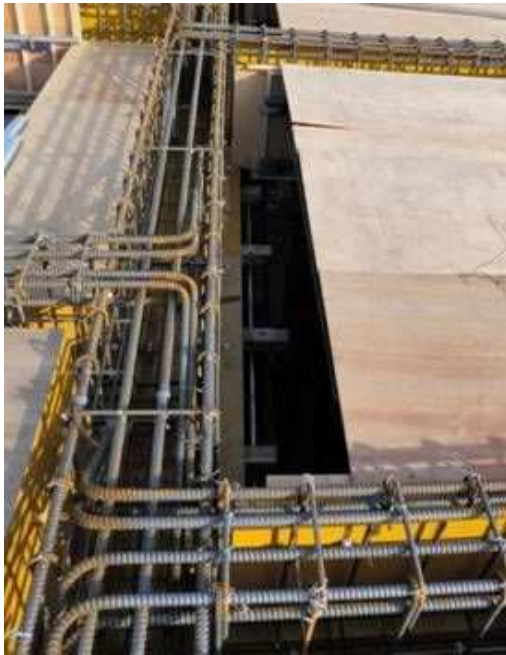
配線前の配筋状態
