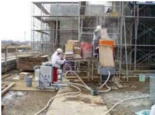
PCグラウト練り混ぜ状況
