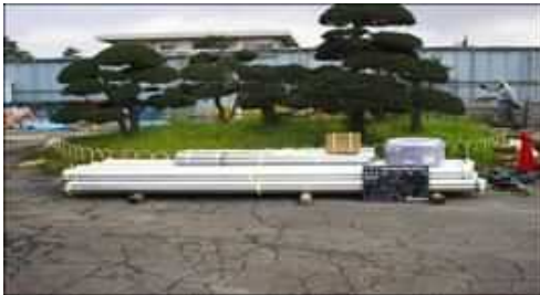
スパイラルシース保管例(シートをはずした状態)
