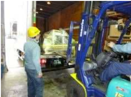
VSL定着具荷降し例(フォークリフトによる)
