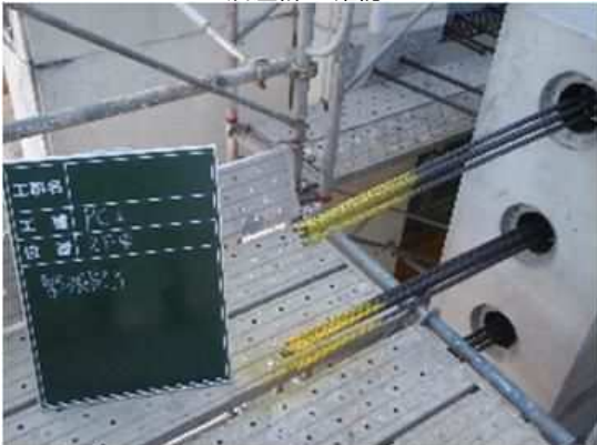
緊張完了確認マークの例
