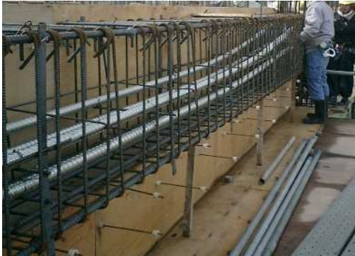
側面型枠開放方式例
