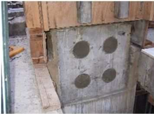
緊張端跡埋め状況
