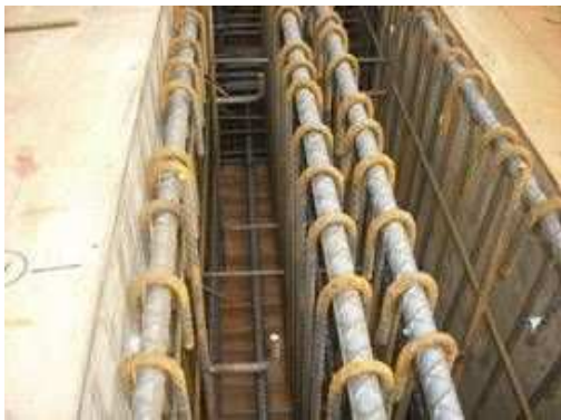
支持台取付け完了 鉄筋タイプ
