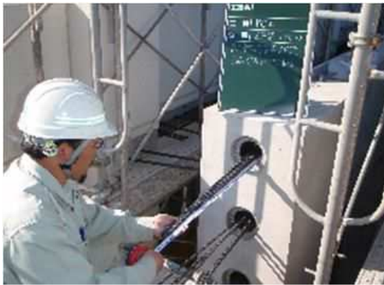
PC鋼材余長確認状況
