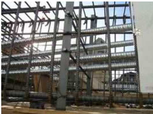
支持台取付け完了 フラットバータイプ
