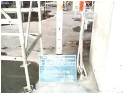
PCグラウト注入確認(排出口)
