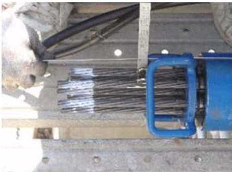
伸び量測定状況
