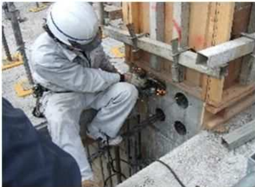
PC鋼材余長切断状況
