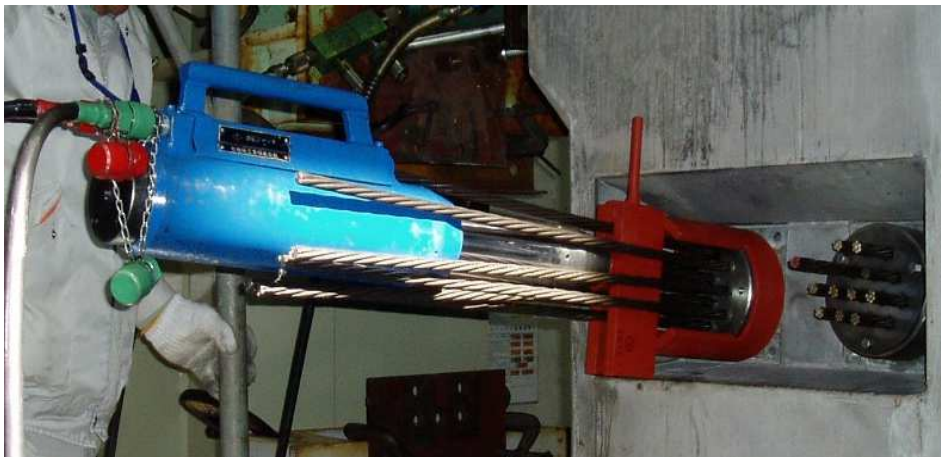
かんざし治具を使用しての単線ジャッキでの除荷
