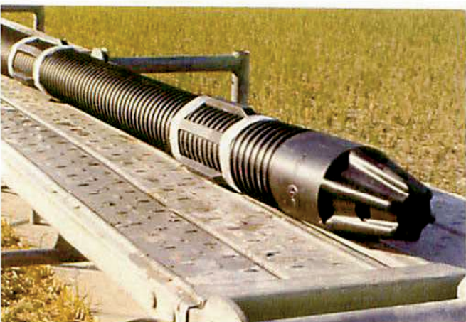
③アンカーケーブルの組み立て完了です。
